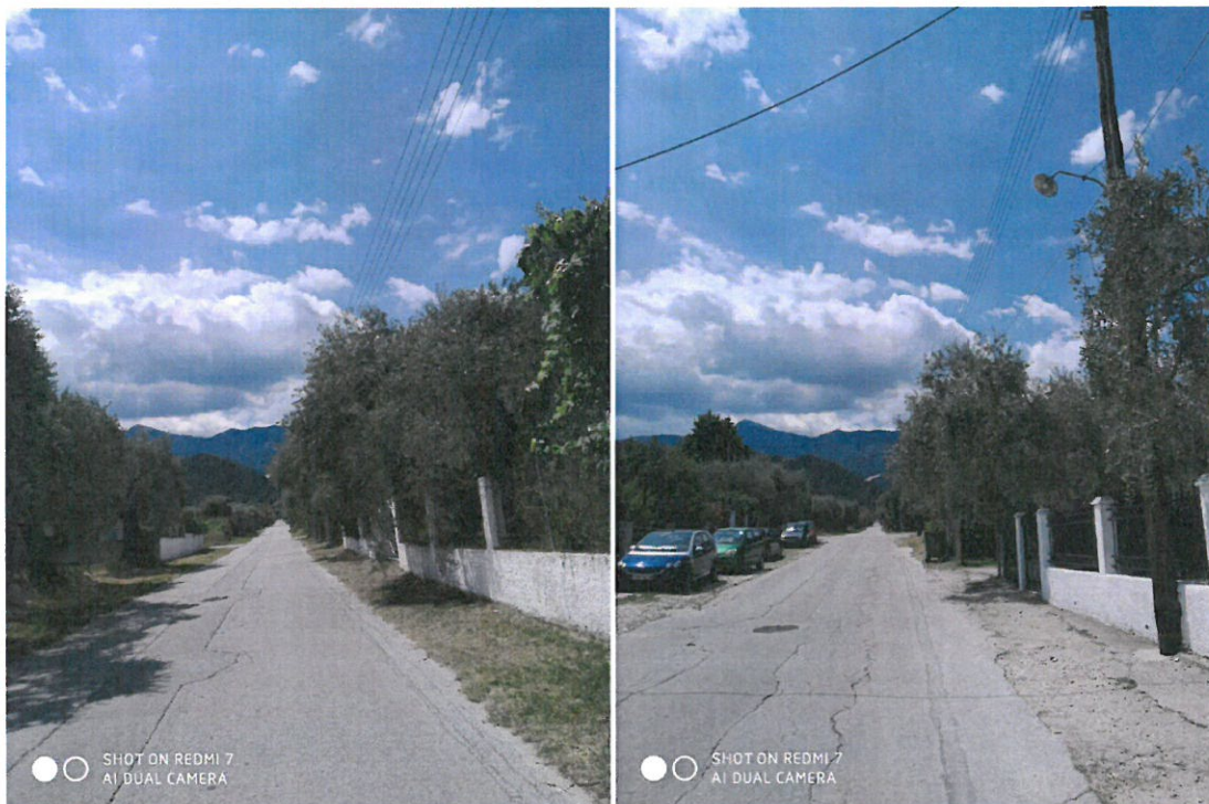
Εικόνα 3: Υφιστάμενη κατάσταση της δεύτερης οδού εντός του Λιμένα.
