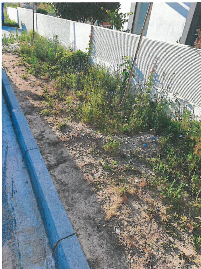
Εικόνα 8: Υφιστάμενα κράσπεδα στην περιοχή «Δαίμονας» στα Λιμενάρια όπου θα γίνουν τα νέα πεζοδρόμια.
